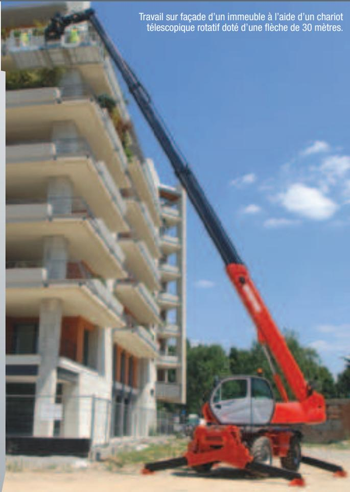
Travail sur façade d'un immeuble à l'aide d'un chariot télescopique rotatif doté d'une flèche de 30 mètres.
