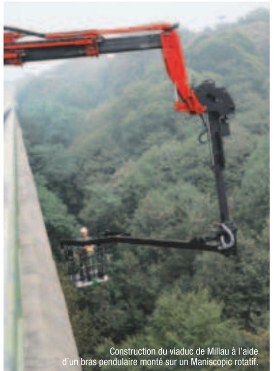
Construction du viaduc de Millau à l'aide d'un bras pendulaire monté sur un Maniscopic rotatif.
